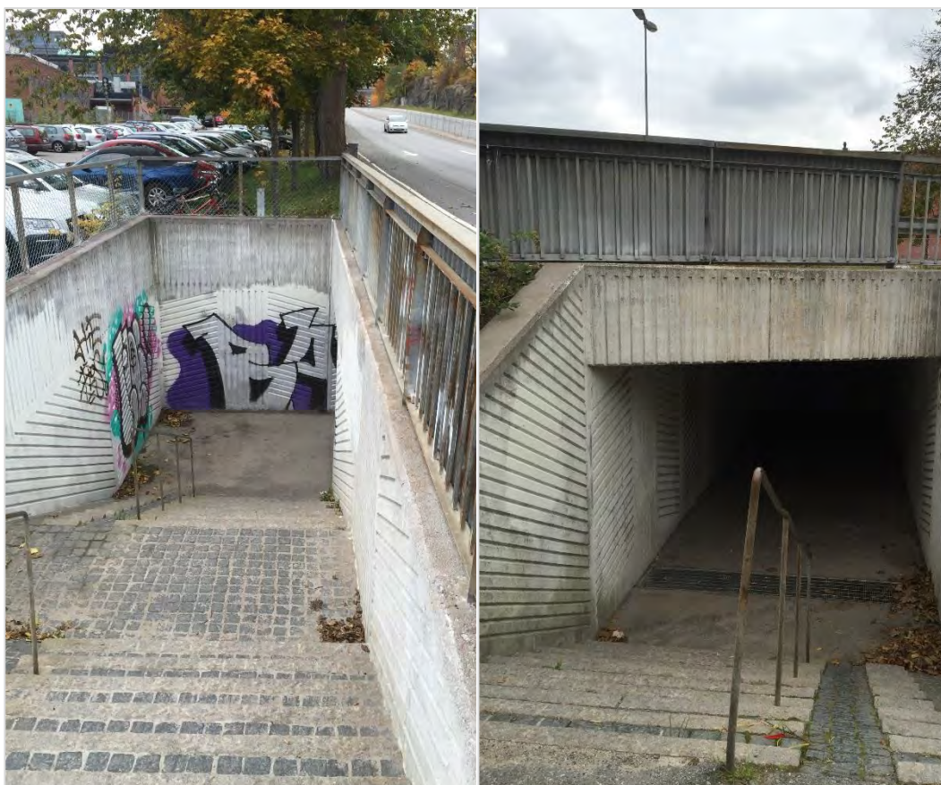
Figur 12. Gångtunnel under Värmdövägen
