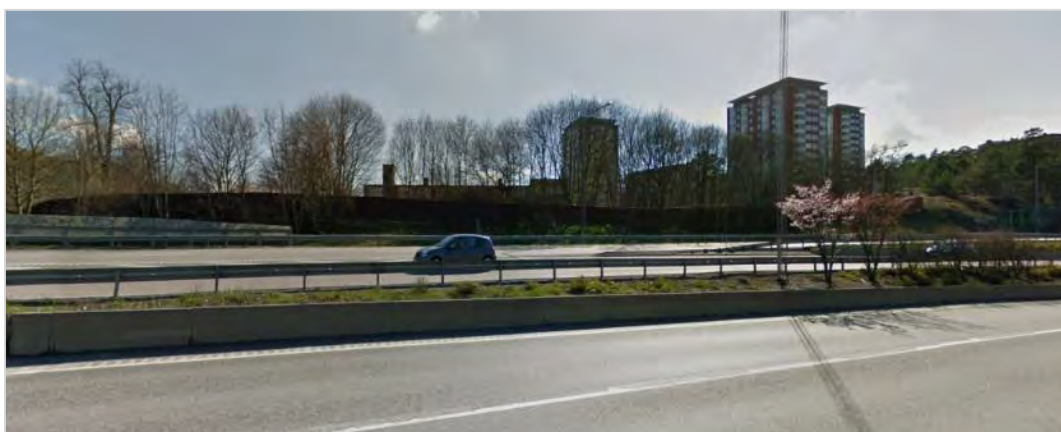
Figur 9. Värmdöledens och anslutningen till Södra länkens sträckning förbi Svindersviks skola, notera höjdskillnader mellan körfält. I mitten av bilden synliggörs den gröna kil/vall som skiljer väg och skolområde åt och på vilken bullerplanket är placerat.
