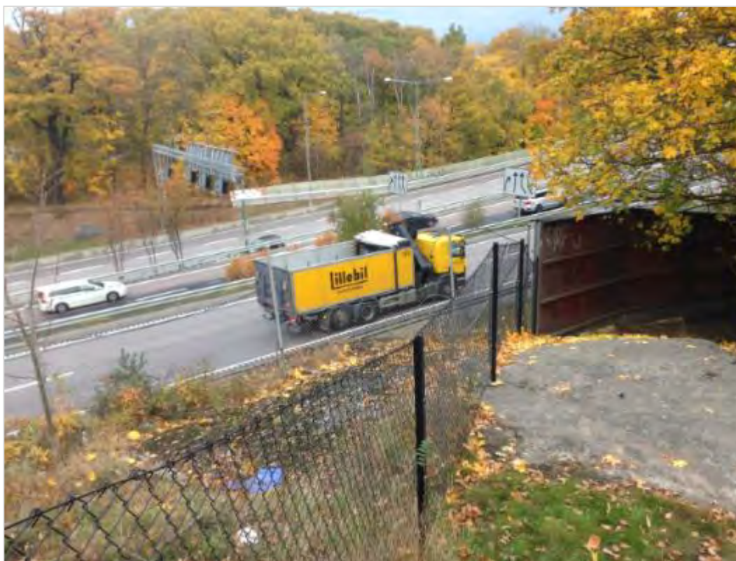
Figur 7. Befintlig bullerplanks utformning. Foton är tagna från båda sidor av planket på olika ställen av bullerplankets sträckning. Längs med Värmdöleden syns även avåkningsskydd vid väggkant. Foton visar även den vall som planket är byggt på och dess förhållande till närmsta skolfastighet. Nedersta fotot visar det bergsparti som ansluter till skolan och där ett stängel avskärmar mot stup/slänt ned mot Värmdöleden.
